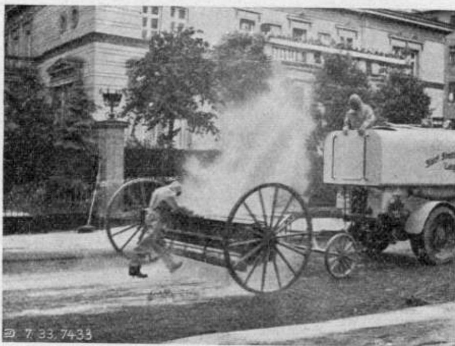
Abb. 86. Sämaschinen können bei der Entgiftung zum Streuen verwendet werden.
