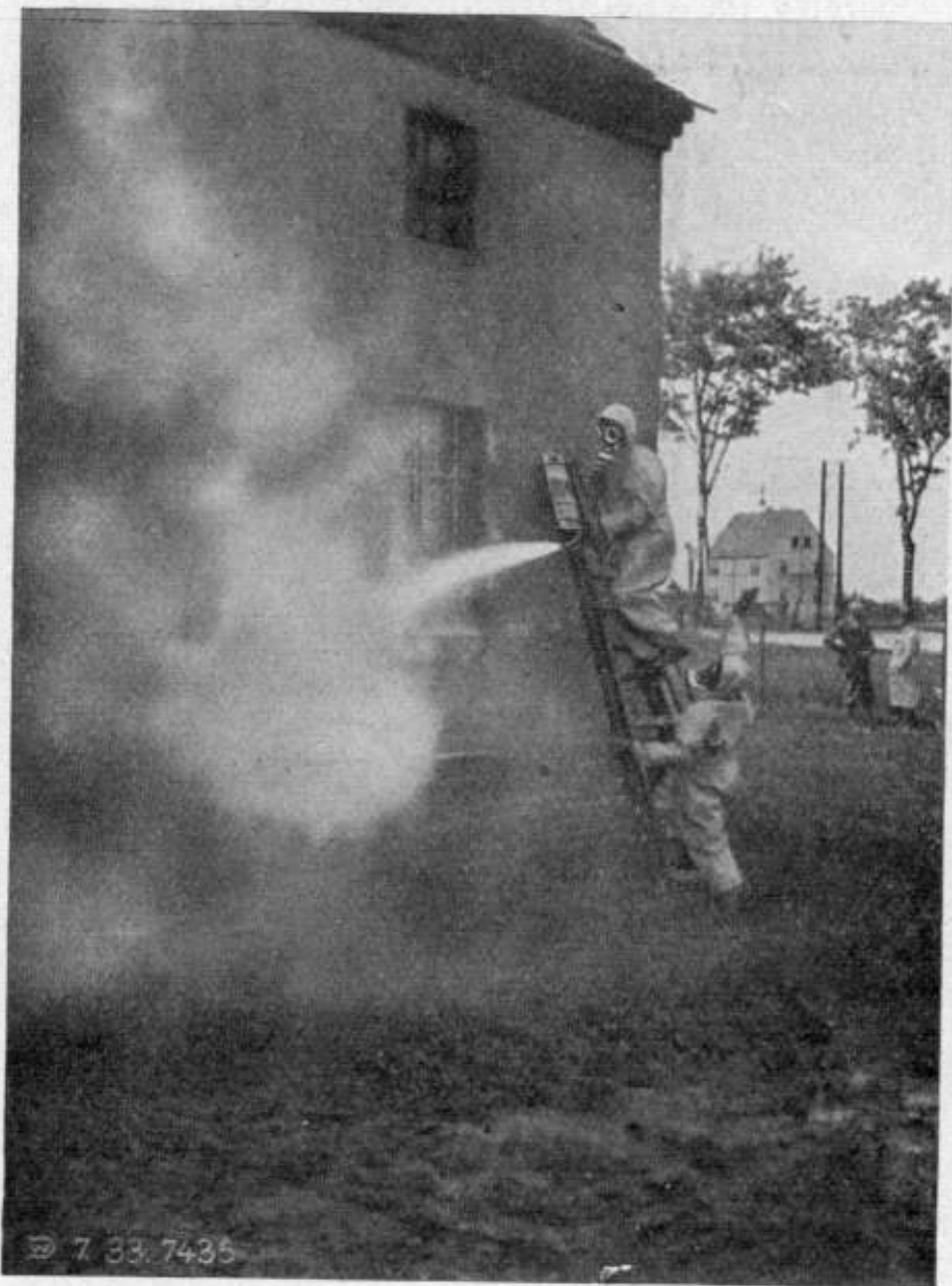
Abb. 88. Entgiftung einer Hausmauer mit Trockenlöscher, der Chlorkalk enthält.
